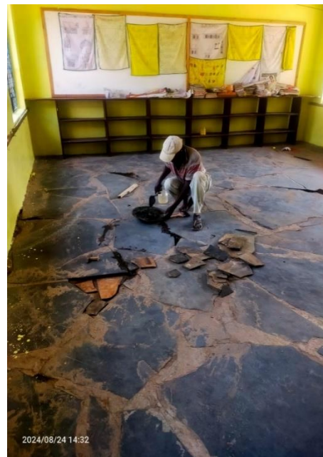
Reparatie van de vloer
